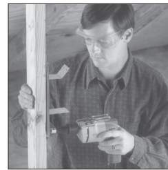
Fixer le support de montage (MB).
