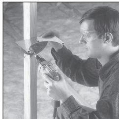
Fixer le support de montage (NB)
